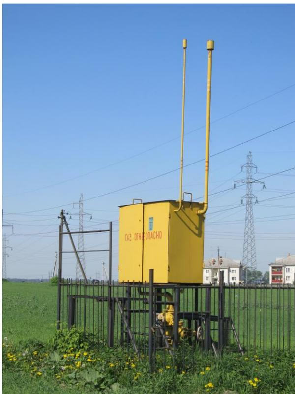
**Рисунок 10. Газорегуляторный пункт.**
